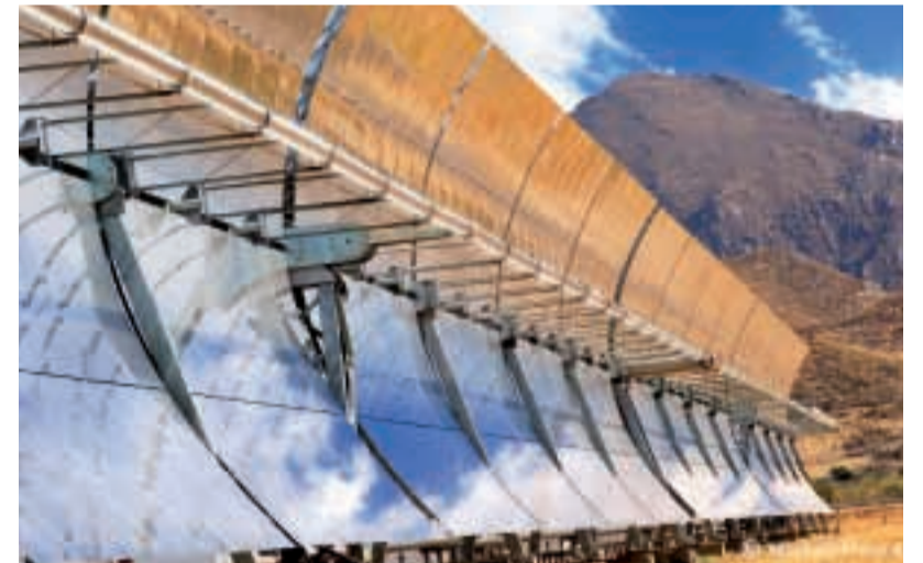
Parabolrinnenkollektor der solaren Direktverdampfungsanlage in Almeria, Spanien ist heute weltweit führender Anbieter von Sonnen- sowie Windkraftwerken und hat 30 000 neue Arbeitsplätze in acht Jahren geschaffen. Bild: M. Steur
