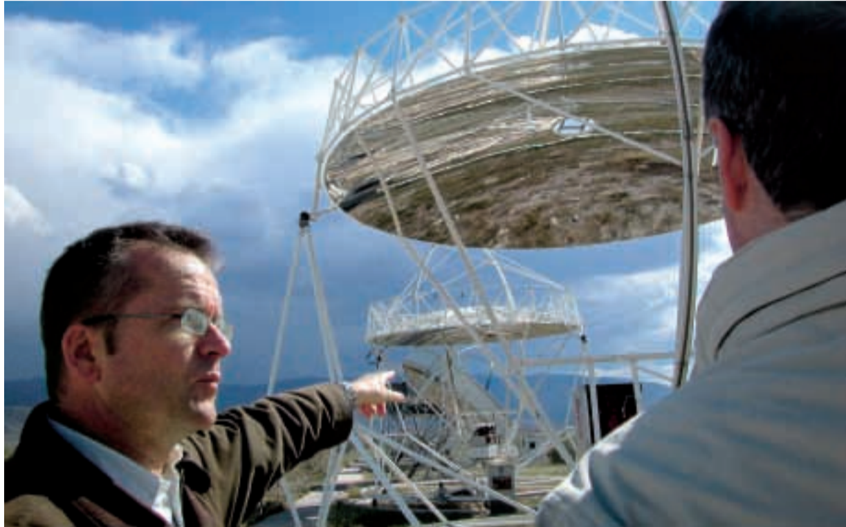
Christoph Richter und Beat Andrist an der Forschungsanlage in Almeria/Spain: In Kombination mit Solaranlagen gilt der Stirlingmotor als dezentral einsetzbares Kleinkraftwerk der Zukunft für südliche Breitengrade. Bild: H. J. Luchsinger
