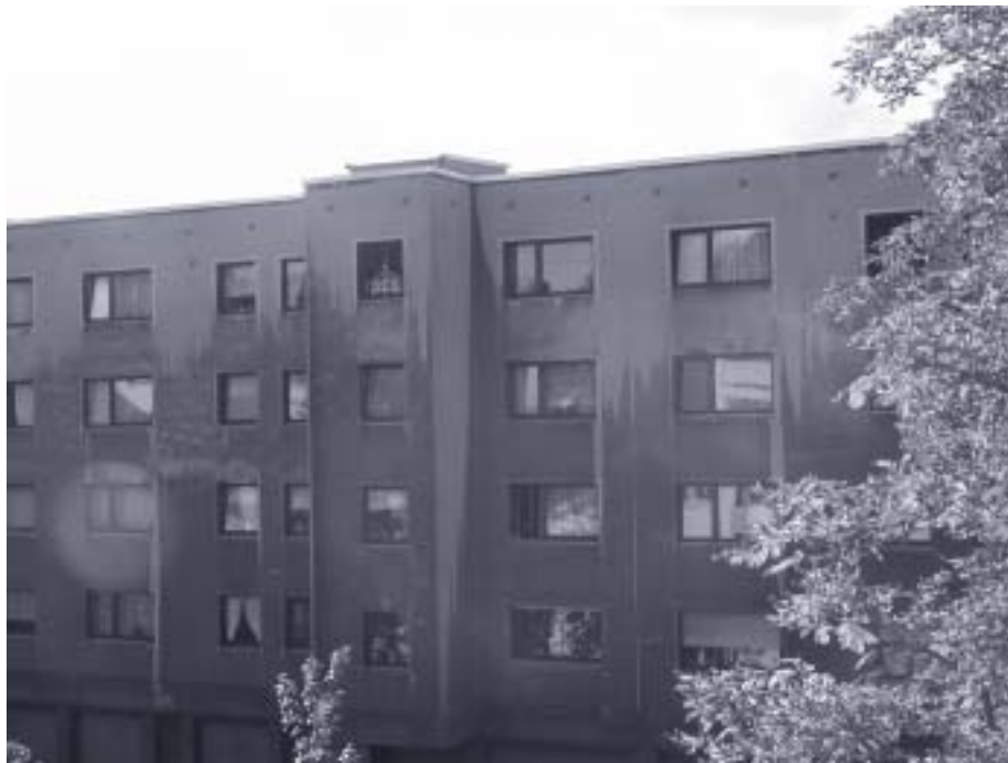
Darf man von einer verwahrlosten Fassade auf schlechte Raumlufqualität schließen?
