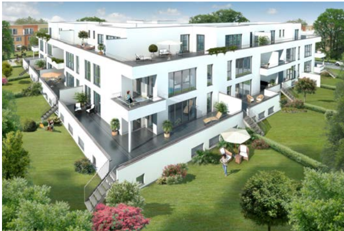
Bild 3: Mehrfamilienhaus mit 18 Wohneinheiten
